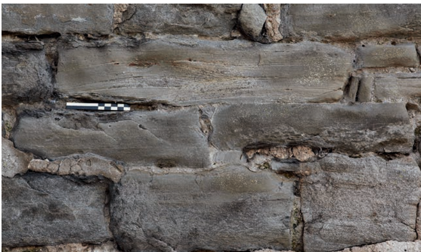
FIG. 30B Detailopname van de muurpartij in fig. 30a: fijnkorrelige groengrijze kalkzandsteen van Baincthun met sedimentaire structuren, waaronder gekruiste gelaagdheid. Vorm en kleur doen denken aan plaatselijke veldsteen. Close-up of the stretch of wall pictured in fig. 30a: fine-grained greenish-grey Baincthun calcareous sandstone displaying sedimentary structures, such as cross-bedding. Form and colour resemble local sandstone.
