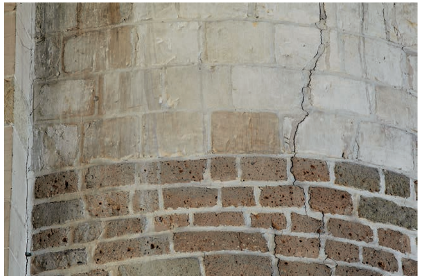
FIG. 7A Traptoren in het hallenkoor van de OLV-kerk. Witte krijtsteen bovenaan, bruine vulkanische tufsteen onderaan. Staircase turret in the hall choir of the Church of Our Lady. White chalk above, brown volcanic tuff underneath.
