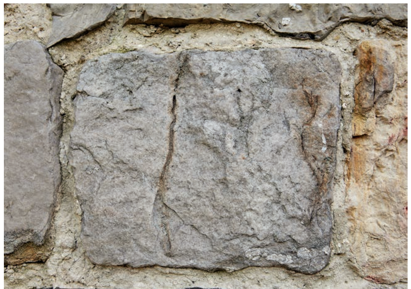
FIG. 12 Atrechtse steen in het gedichte portaal van de weststoren. Bleekgrijze tot crèmekleurige fijnkorrelige kwartsrijke zandsteen (kwartsareniet) met saccharoïd aspect en opvallende verticale wortelsporen.
