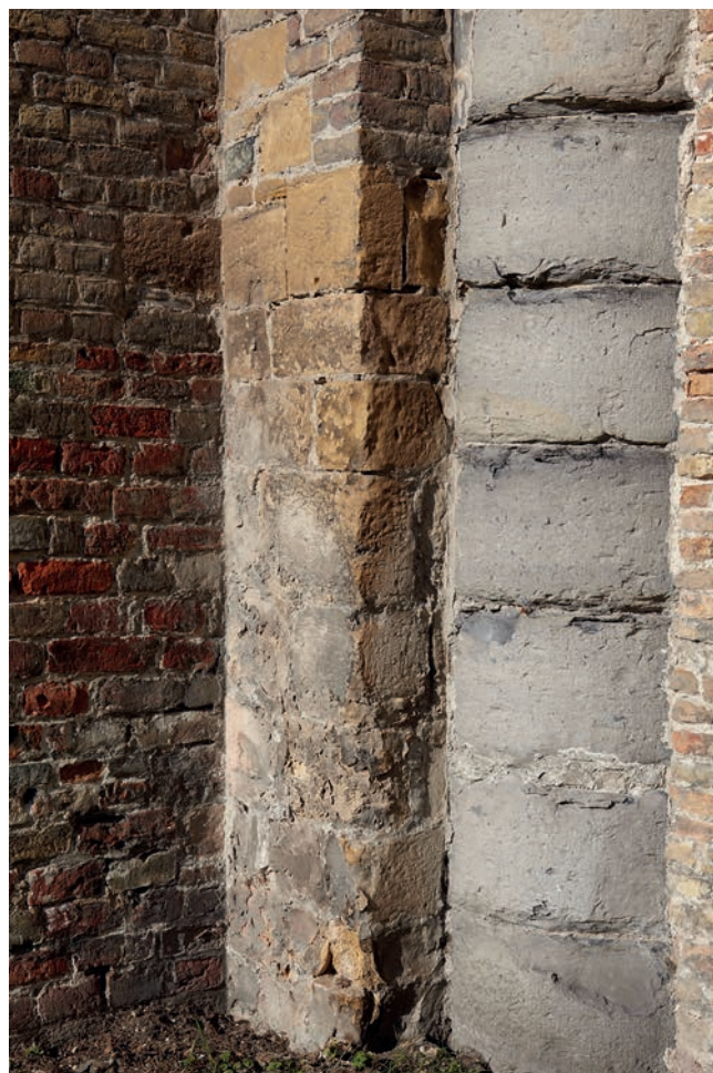
FIG. 27 Hoek van middenschip en weststoren, zuidzijde. Rechts een zuil in blokken bleekgrijs gepatineerde Doornikse kalksteen, links een halfpijler in geel gepatineerde en alveolair verwerende steen van Caen.
