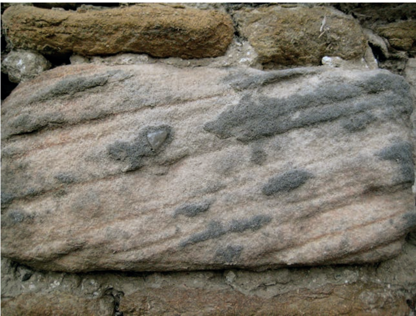
FIG. 13B Macroscopische detailopname van vorige foto: schuin gelaagde zandsteen van Le Quesnoy met afgebladderde vuilkorst en centraal een driehoekige glazige kwartskei.
