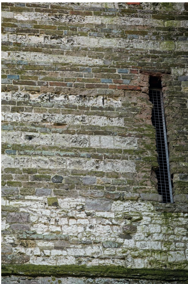
FIG. 26 Weststoren, noordwand, tweede bouwlaag. Speklagen van witte krijtsteen, baksteen en rozig bruine vulkanische tufsteen. Western tower, north side, second storey. Alternating layers of white chalk, brick and pinkish-brown volcanic tuff.
